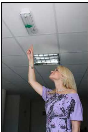
Obr.: Nouzové osvětlení
