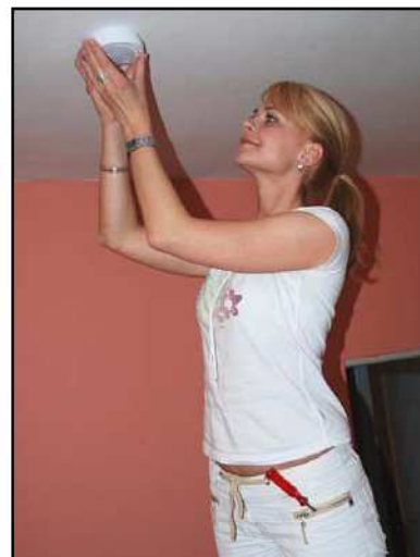
Obr.: Instalace hlásiče kouře
