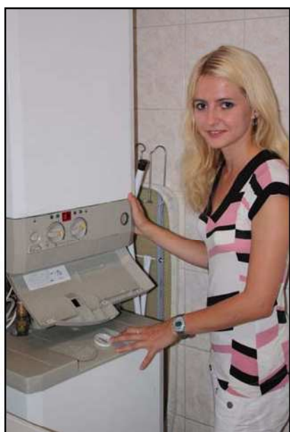
Obr. Pravidelná kontrola kotle
