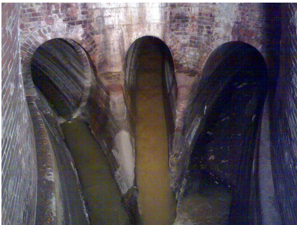
Obrázek 6 – Pražská kanalizační stoka 1
