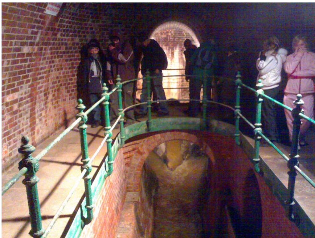
Obrázek 11 – Pražská kanalizační stoka 2
