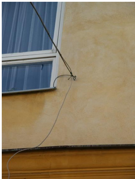
Obr. 8 Ukotvení na budově gymnázia
