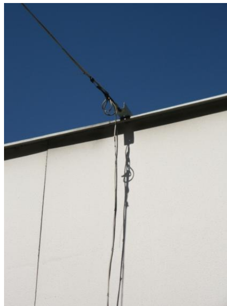
Obr. 9 Ukotvení na budově základní školy
