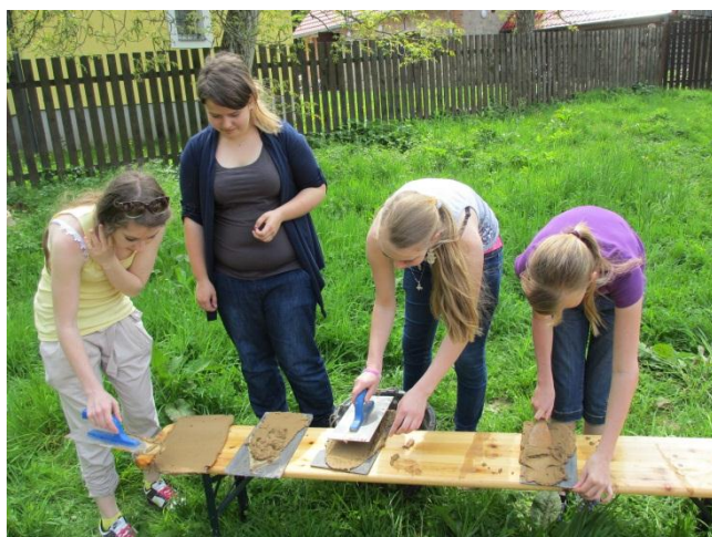
Vyhladíme štuk až ke krajům destičky tak, aby vznikla hladká rovnoměrná vrstva o tloušťce 1-2 cm.
