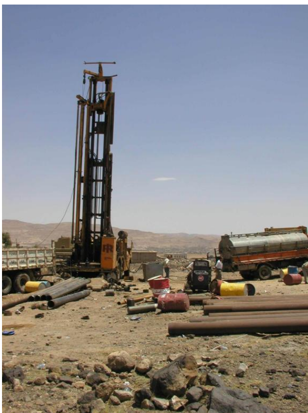
Vrtání studně v oblasti Amran, Jemen
